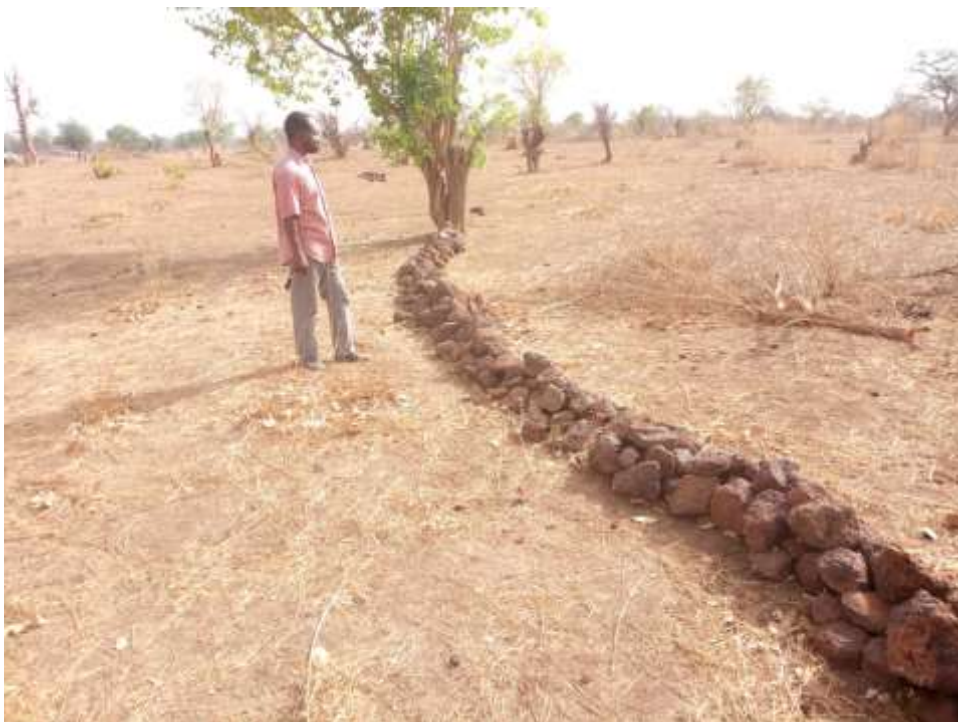
Installation de cordon pierreux à Sandaré
