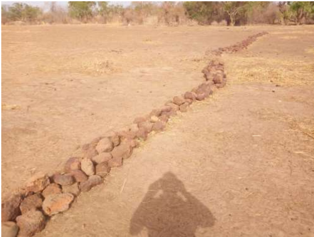
Installation de cordon pierreux à Sandaré
