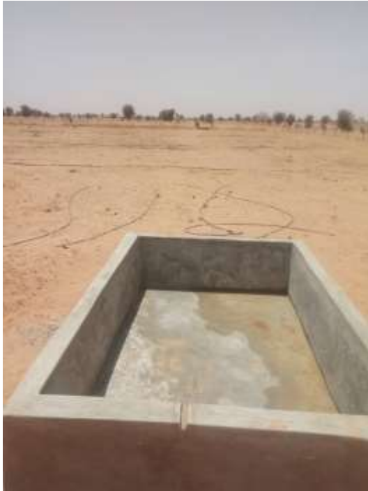
Conversion du système goutte à goutte en bassins à Baniré
