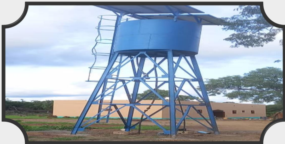
CSCOM de Bouraba avec un système d'adduction d'eau solaire
